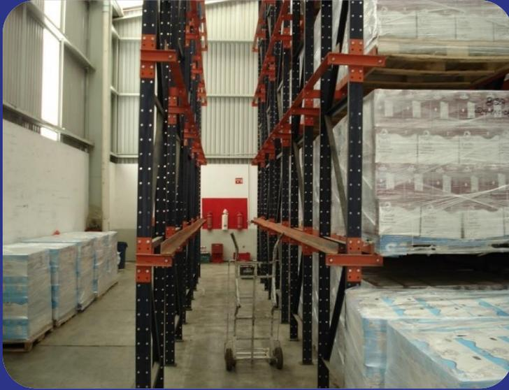
Diseñado específicamente para permitir el acceso de montacargas a su interior, esto aumenta la capacidad de almacenamiento horizontal, reduciendo la cantidad de pasillos necesarios para acceder el producto.
