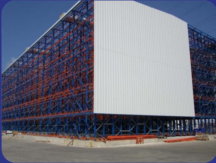
En este sistema, son los Racks los que soportan todos los esfuerzos propios del edificio, ahorrándose con ello la construcción de la estructura del almacén.
